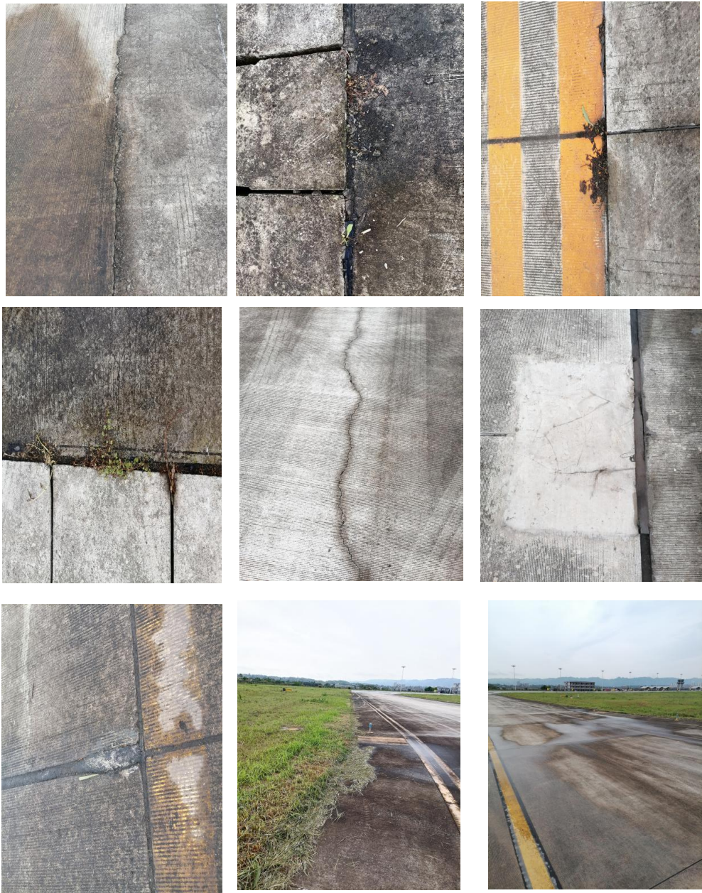
图 5 现场调查图片
